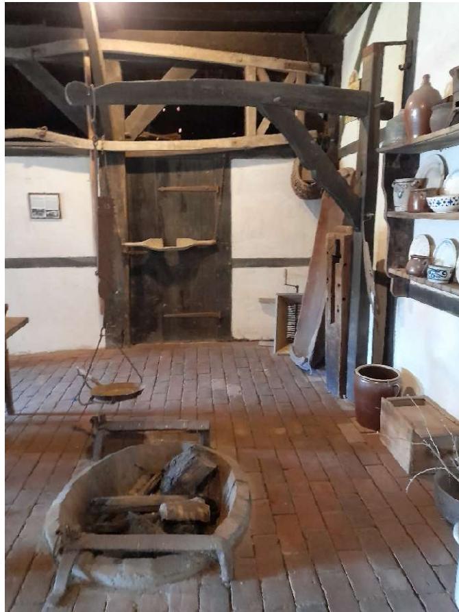
Foto: Blick auf die Feuerstelle des Hauses, Zustand 2023.
